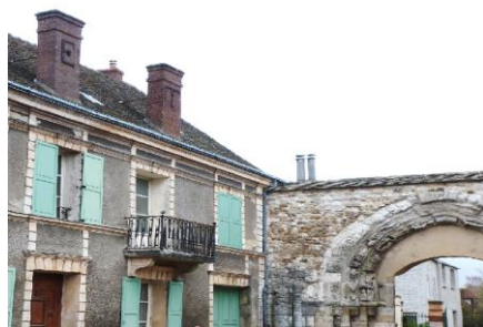
Lettres sur les cheminées de la maison porte de l'Abbaye
