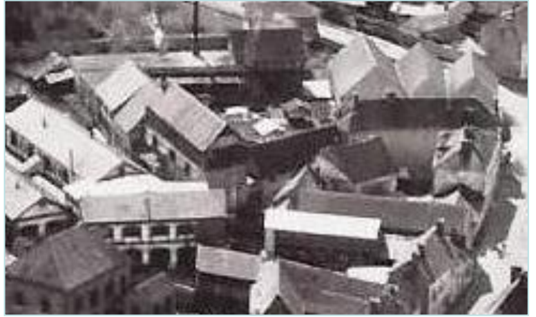
Vue aérienne des anciennes tanneries DEMANTKÉ (aujourd'hui Ets DOUCHEZ) on y voit les abris coiffant les fosses de tannage)
